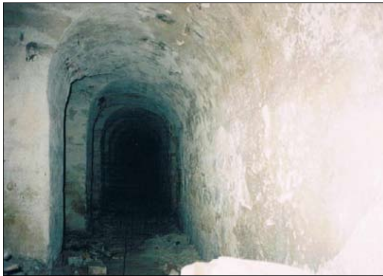
Ремонт Магдебургских казарм, 1996 Фото Е.Макаровой
